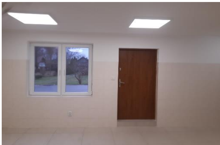
Odnowione wnętrze remizy we Franciszkowie
