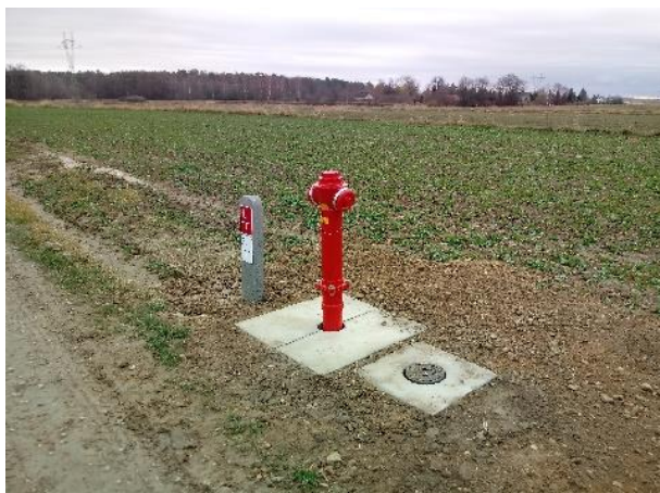
Budowa wodociągu w Strzyżewicach i Dębinie
