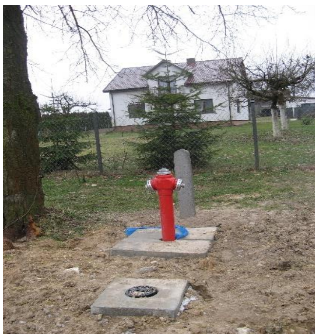
Sieć wodociągowa w Osmolicach Drugich
