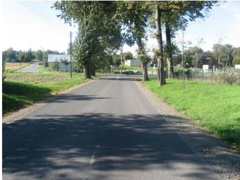
Przebudowa drogi gminnej nr 107132L w Strzyżewicach
