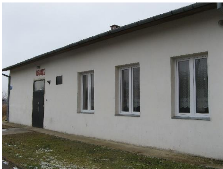
Wymiana okien i drzwi w remizie w Strzyżewicach
