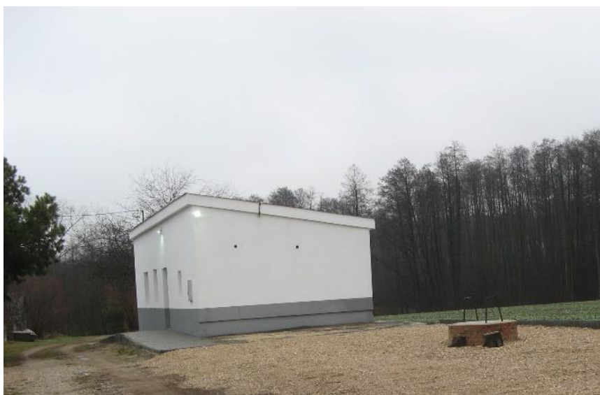
Odnowiony budynek w Iżycach
