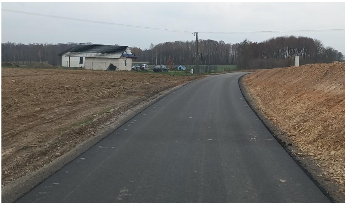
Nowa droga w Kolonii Kielczewice Dolne
