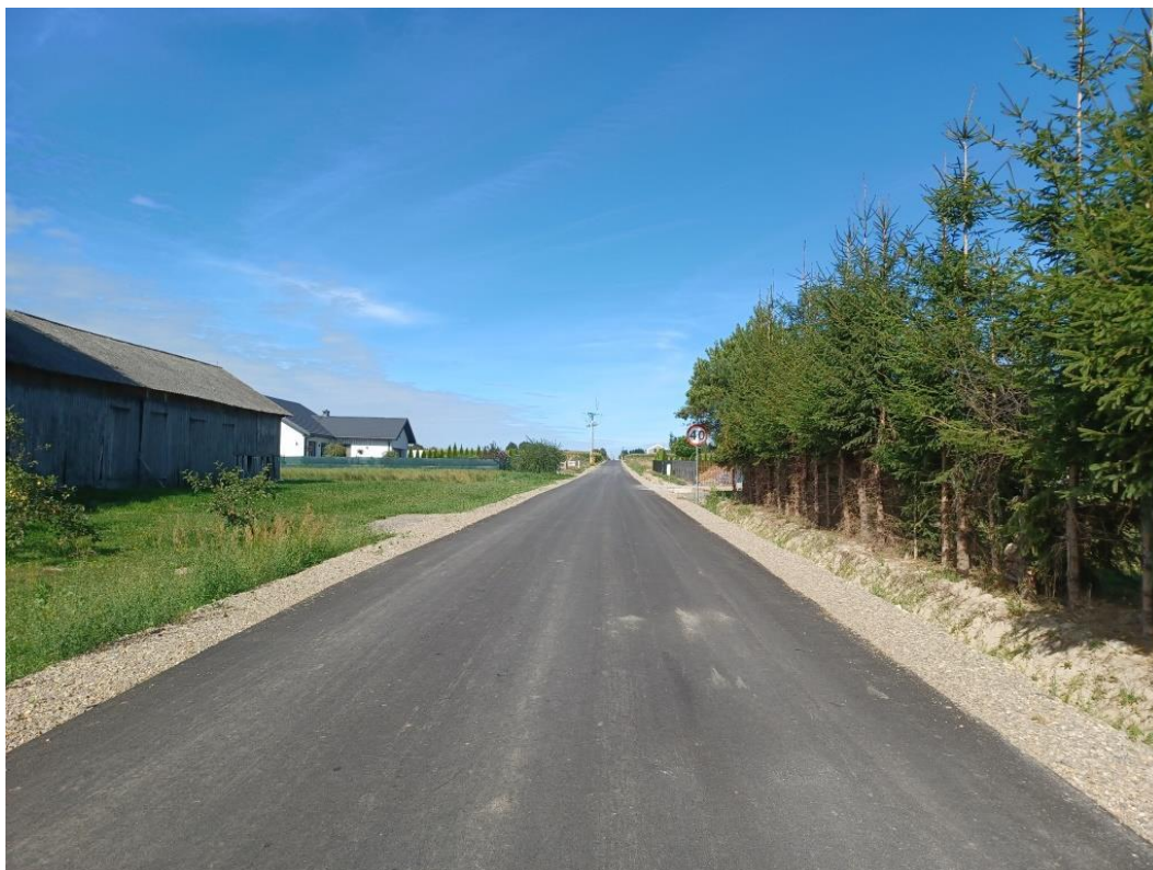
Droga w Bystrzycy Nowej po przebudowie
