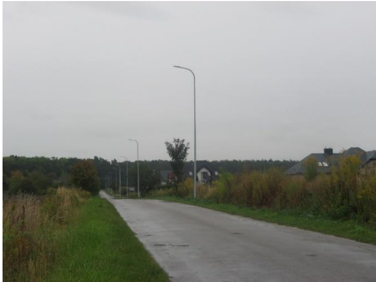
Oświetlenie drogowe w Żabiej Woli
