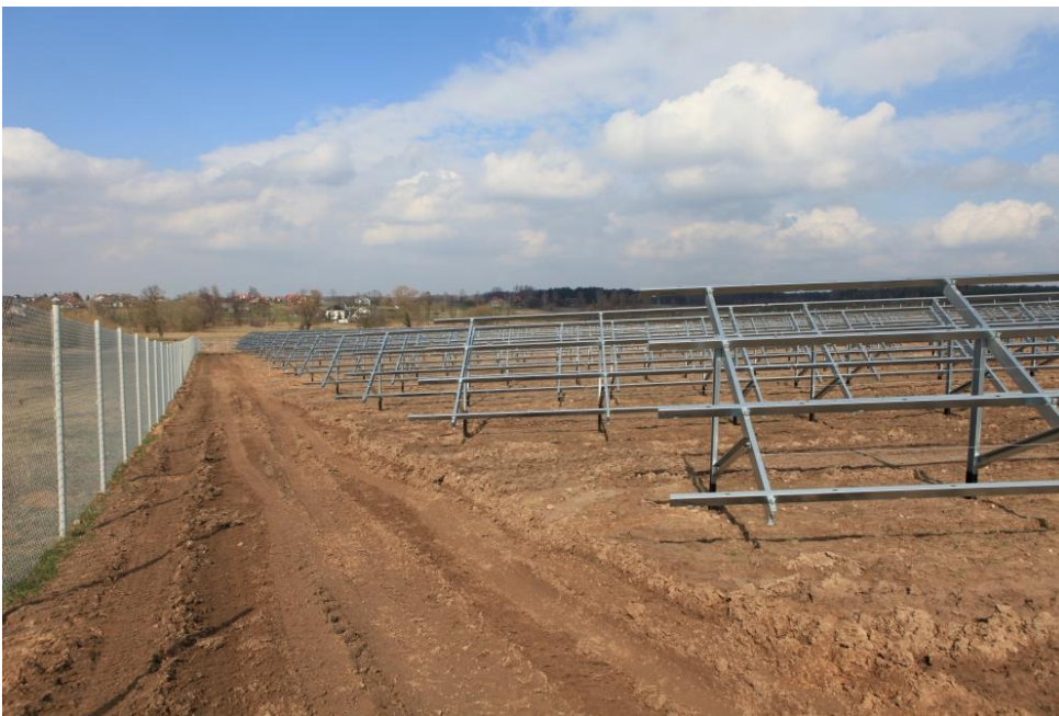
Przykładowa instalacja gruntowa
